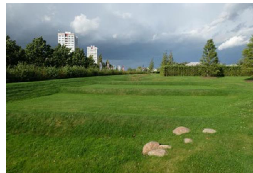
Obr. 10: Vsakovací nádrž v Berlíně (internetový zdroj)
