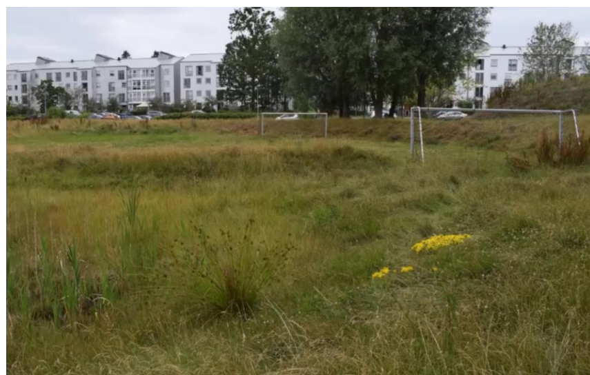
Obr. 15: Suchá retenční dešťová nádrž využívaná jako prostor pro hru (foto: M. Vysoký)
