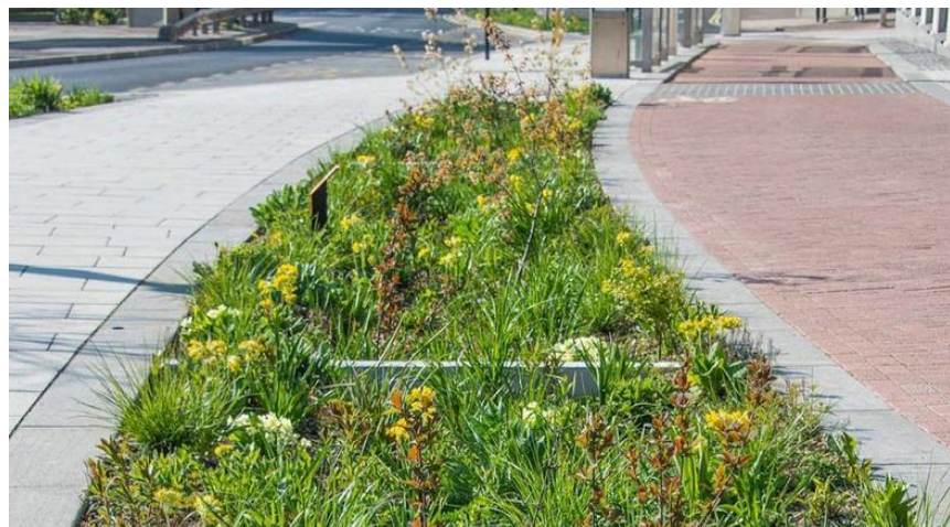
Obr. 12: Vsakovací průleh s regulovaným odtokem, který lze nazvat dešťovým záhonem, v Sheffieldu (foto: N. Dunnett)
