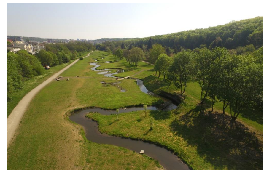
Obr. 24: Revitalizace Rokytky nad Hořejším rybníkem 2014-2015 (internetový zdroj)
