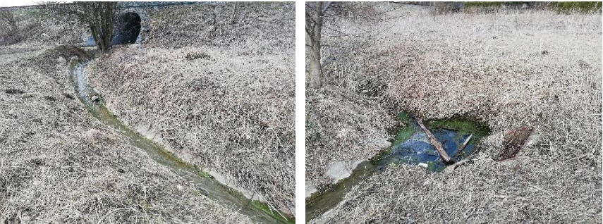
Obr. 59: Přechodový úsek mezi "poldrem" a zatrubněním (foto: autorka)
