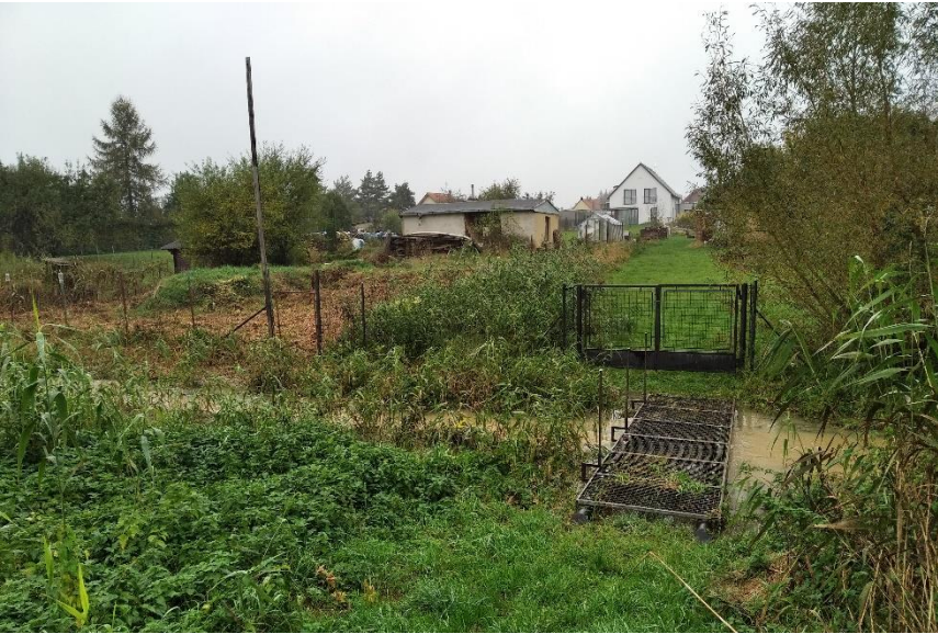
Obr. 63: Úsek C při silných deštích – průtok je regulovaný, ale voda opouští koryto (foto: autorka)
