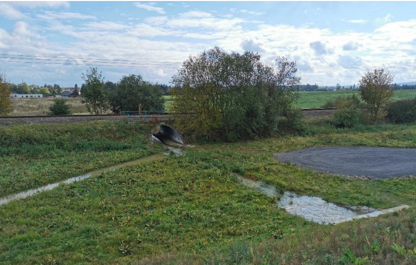
Obr. 58: K regulovanému odtoku z "poldru" se přidává boční přítok, foceno po období s vysokým srážkovým úhrnem (foto: autorka)
