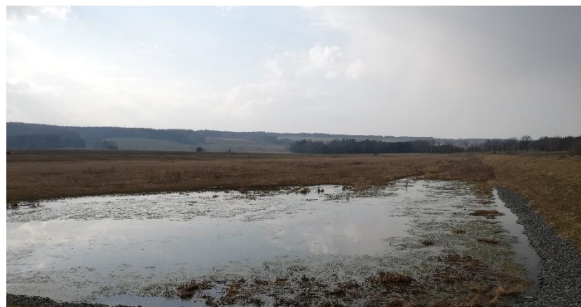
Obr. 38: Průtočná retenční nádrž s mokřadní plochou na Studeném potoce (foto: autorka)
